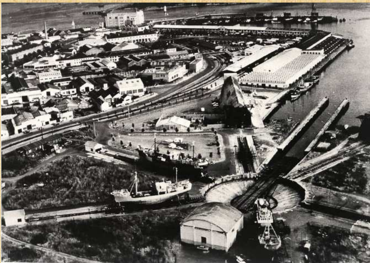
Le slipway du port de pêche de Lorient en 1965, et les sept voies de carénage en étoile. Extrait du livre « Lorient Keroman », de Gérard Le Bouëdec et Dominique Le Brigand. | ARCHIVES MUNICIPALES DE LORIENT
