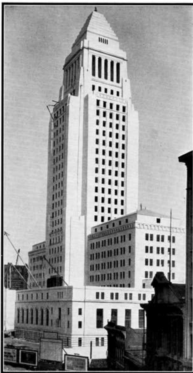
Les cités de grattes-ciel de l'avenir seront loin d'être laides. Leurs constructions en fer et en ciment réuniront l'utile à l'aspect décoratif comme le montre cette photographie de l'Hôtel de Ville de Los Angeles.
