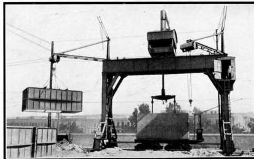
(En bas) Photographie d'une grue à portique soulevant un bloc de ciment d'un truck, pour le transporter au port.
