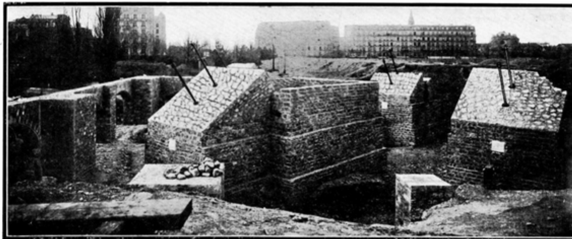
(Ci-dessous). Etablissement des fondations en maçonnerie de la Tour.
