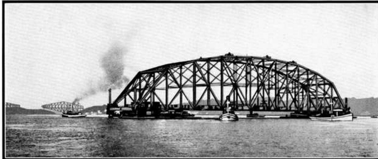
(Dessus) La portée centrale reposant sur les pontons, pendant son transport, au centre du pont. On voit, au fond, les deux cantilevers prêts à recevoir cette portée. (Dessous) L'un des grands joints à l'extrémité de la poutrelle principale.
