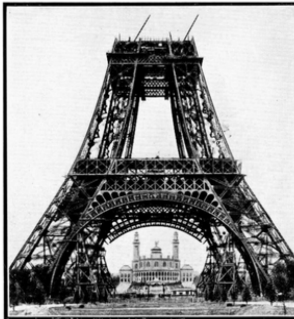
(Ci-dessous). La construction de la Tour a atteint la seconde plateforme.
