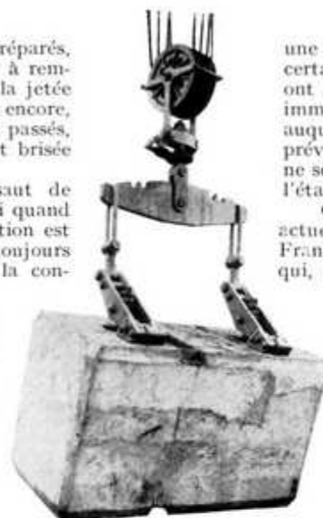
(Dessus) Bloc de ciment maintenu en position par un engrenage Fidler. (Dessous) Modèle Meccano de l'engrenage Fidler reproduisant tous les mouvements de l'original.
