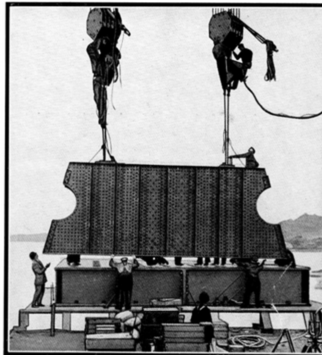
(Dessus) La portée centrale amenée sur le fleuve et attachée aux chaînes de levage des cantilévrs va être levée et mise en place. Cette photographie fut prise le 11 Septembre 1916 juste avant l'accident. (Dessous) On voit les ouvriers en train de poser l'une des parties du sabot principal.
