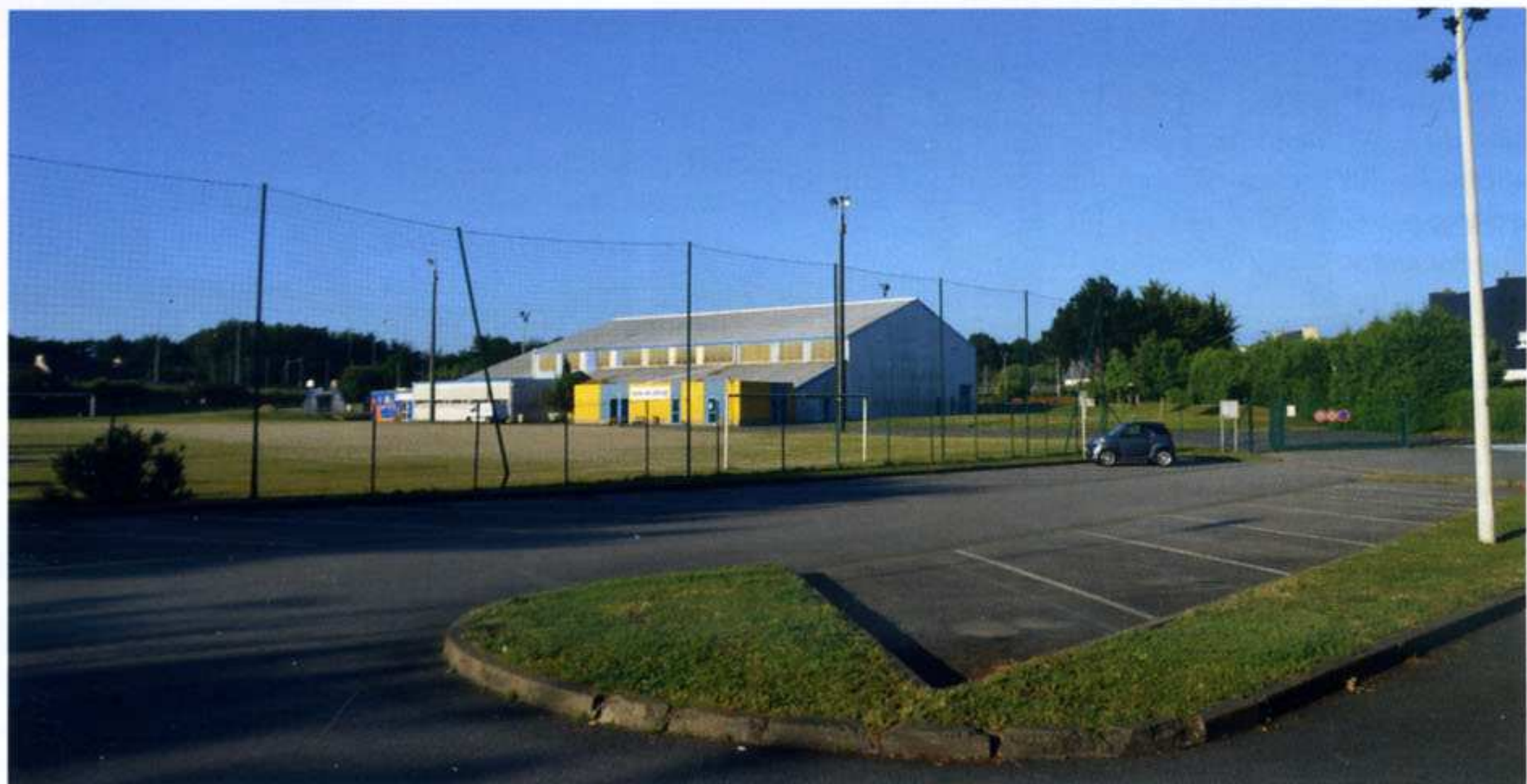
Fig. 3 La salle dans son environnement
